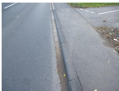
Abbildung 32: Nicht abgesenkte Bordsteine bremsen die Abfahrt von der Fahrbahn aus
