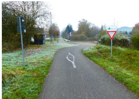
Abbildung 29: Verbindung Bitburg – Hüttingen an der B 50
