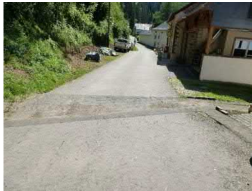
Abbildung 33: Kylltalradeg mit kaum wahrnehmbarer Rinne in Gefällestrecke
